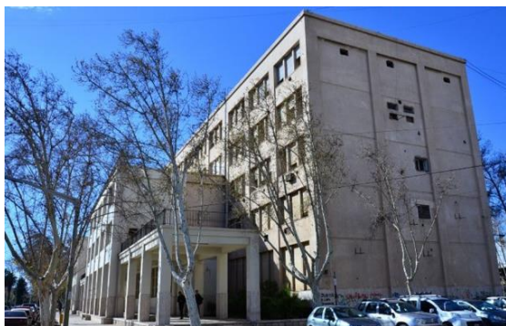
Edificio 9 de Julio.
