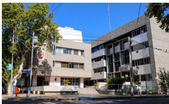
Edificio de la Municipalidad de la Ciudad de San Juan.
